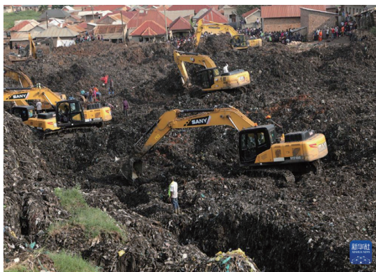
■ 图片来自新华社：8 月 11 日，在乌干达首都坎帕拉的基蒂济垃圾填埋场，工程机械在坍塌事故现场工作
