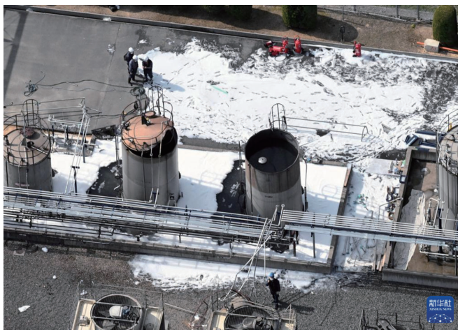
■ 图片来自新华社：这是 4 月 28 日在日本广岛县三次市拍摄的爆炸后的制药厂储罐
