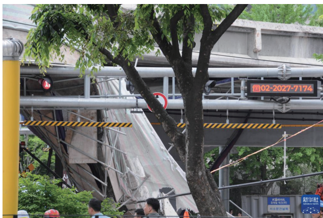
图片来自新华社：这是 5 月 26 日在韩国首尔拍摄的高架桥坍塌事故现场
