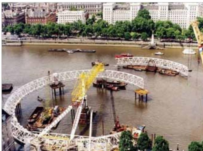
(a) 水平状态下安装摩天轮
