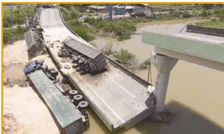
2015年6月19日凌晨3时许，粤赣高速广州往河源方向城南互通CK0 + 224.5匝道桥梁发生断裂，正在匝道行驶的车辆坠落，造成一人死亡、四人受伤。
