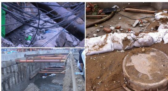
图3 车站涌水事故反映的水管、水井、旱河等可能造成异常水压的周边设施
